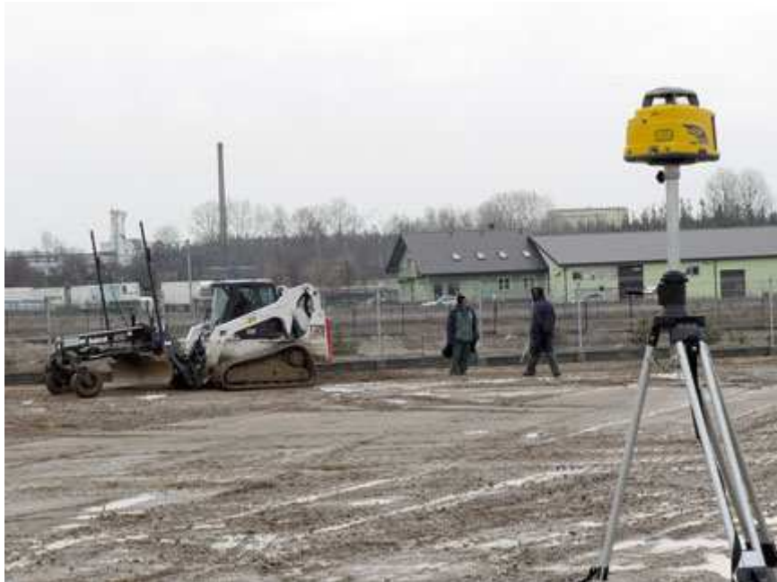
Równiarka w akcji. Na pierwszym planie dwupłaszczyznowy nadajnik laserowy Spectra Precision
