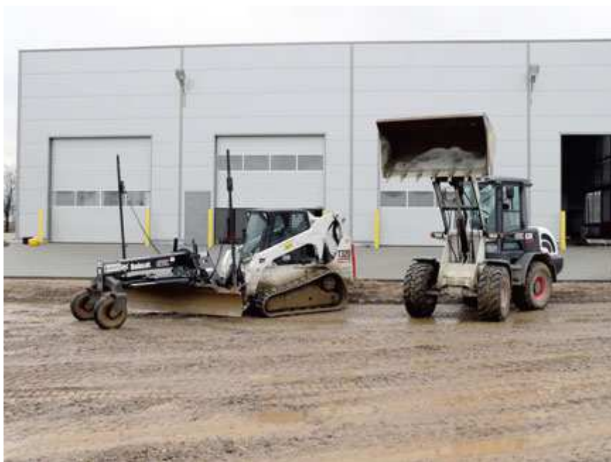
Dwa ostatnie nabytki firmy Abies – miniladowarka T320 z równiarką i ładowarka przegubowa AL350E**A, prezentują się przed halą firmy Geotrans
